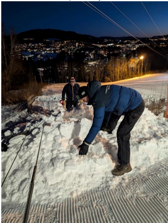
Manuelt arbeid med å få snø på brua
