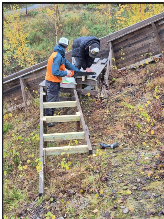
Bygging av rampe i k20.
